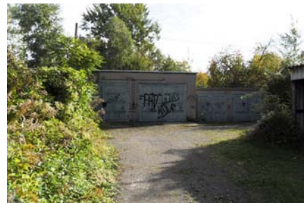
(8): Garagenkomplex, verschlossen (in Nutzung)
