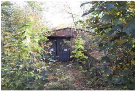
(10): verpachtetes Lagergebäude marode Substanz, verschlossen
