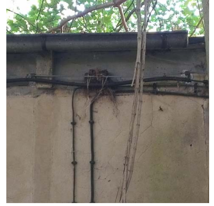
(12): Amsel: altes Nest an Außenfassade
