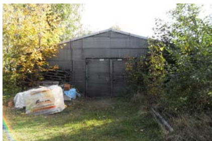
(9): Blechhalle, in Nutzung
