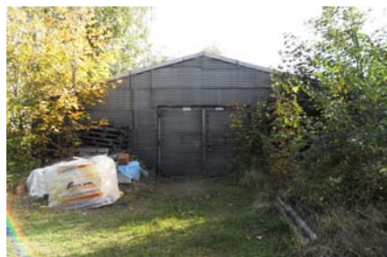
(9): Blechhalle, in Nutzung
