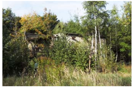
(4): leerstehendes Wirtschaftsgebäude, marode Gebäudesubstanz
