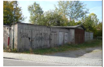
(4): Garagenkomplex in Nutzung
