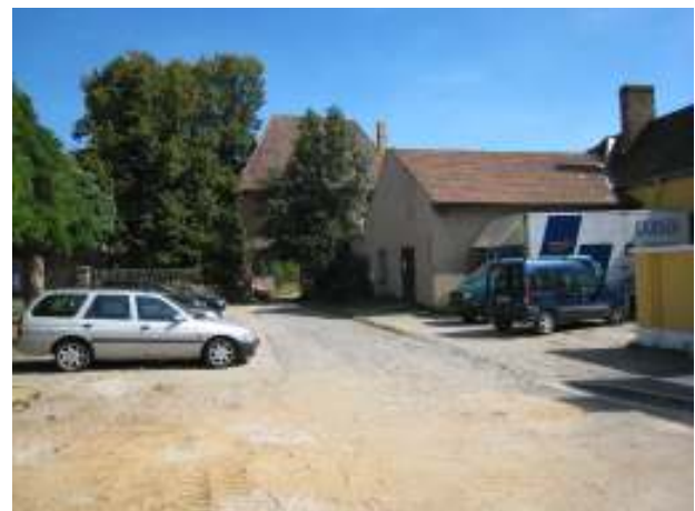
bauliche Mängel im Platzbereich vor der Kirche Großstädteln
