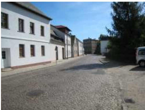
bauliche Erschließungsmängel Alte Straße, Großstädteln
