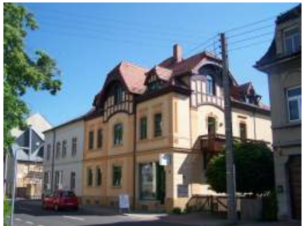
Sanierte Bausubstanz Hauptstraße 299
