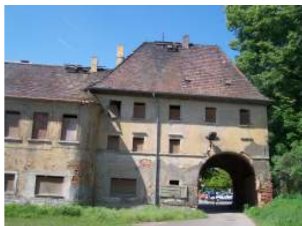
Einfahrt zum Gutsgelände Großstädteln
