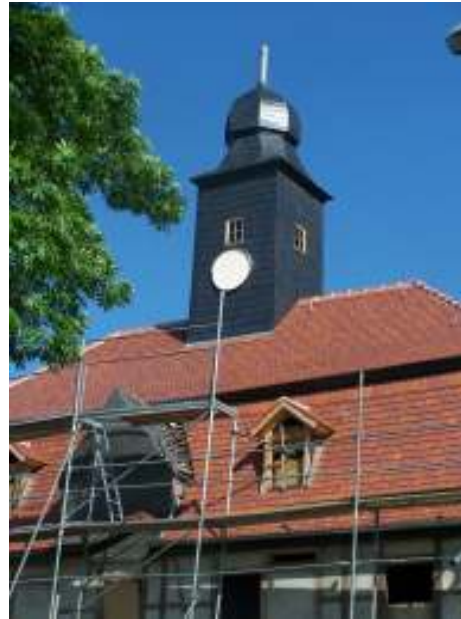
Napoleonhaus im Gelände Gutshaus Gaschwitz
