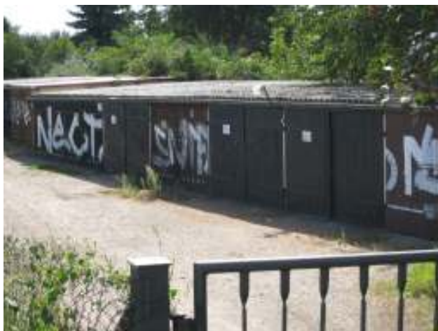
Garagenanlage Kleine Aue an der Pleiße
