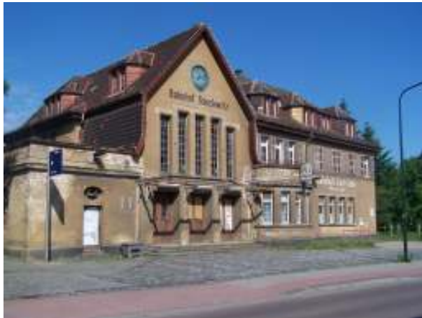
leerstehende Bahnhofsgebäude Gaschwitz
