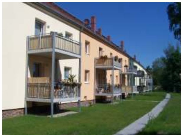
Sanierte Wohnzeile Hans-Steche-Weg 2-12
