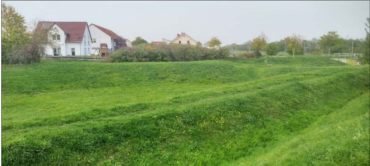
Abb. 9: Beispiel für einen begrüntem Überflutungsschutzgraben
