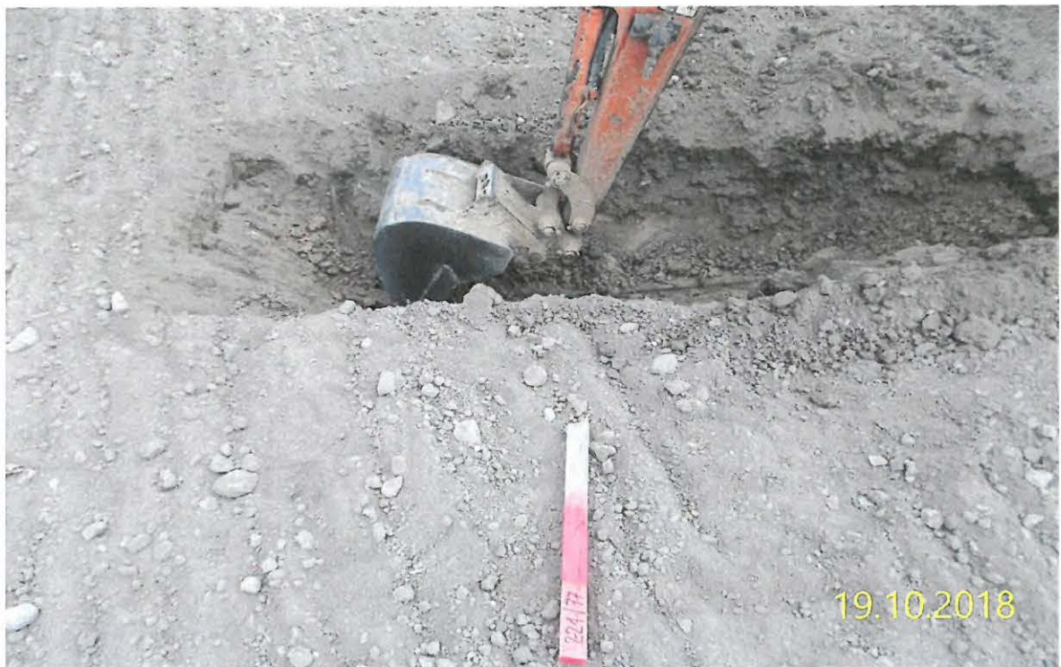
Bild 2: Schurfarbeiten
