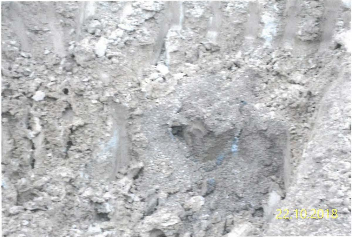
Bild 3: Zustand des aufgesuchten FiBr
