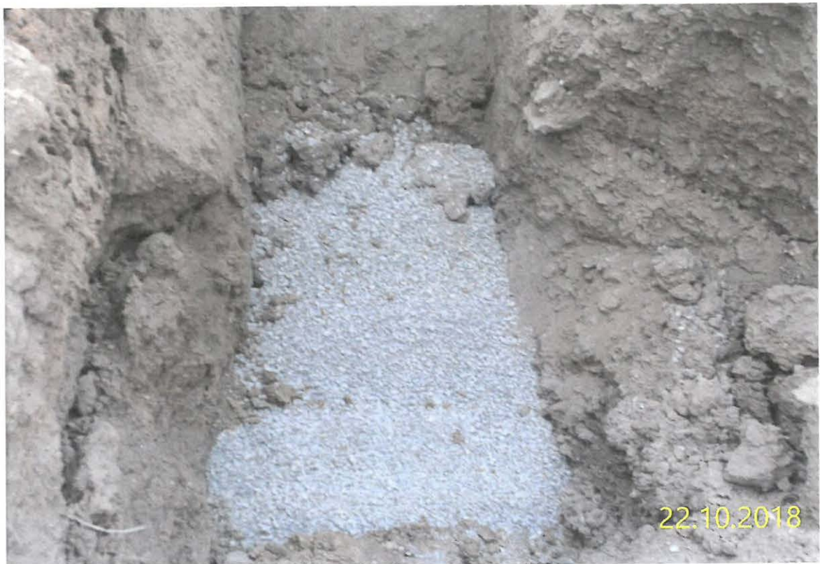
Bild 6: Einbringen Dichtschicht
