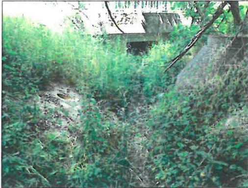
Querung Chemnitzer Straße Regenwasserzulauf aus Richtung Verwaltung JVA
