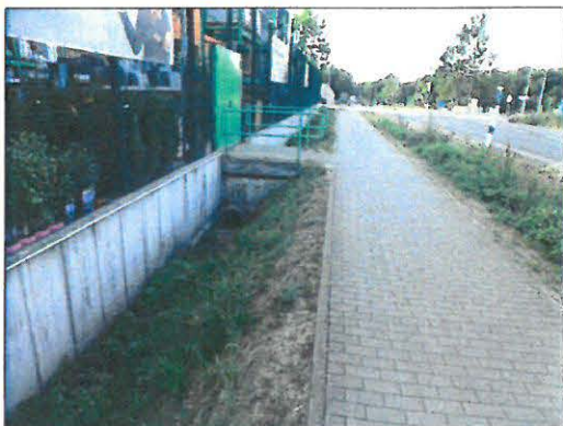
offener Graben am Baumarkt und Straßenmulde
