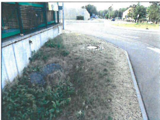
Einbindung des offenen Grabens in die Entwässerung des Kreisverkehrs
