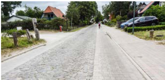
Abb. 53 Radfahrerfreundliche Oberfläche auf historischer Pflasterstraße (Born / Mecklenburg-Vorpommern), Quelle: Radverkehrskonzeption Freistaat Sachsen, 2019
