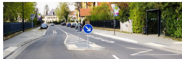
Abb. 60 Friedrich-Ebert-Straße mit bestehender vorbildlicher Querungsanlage
