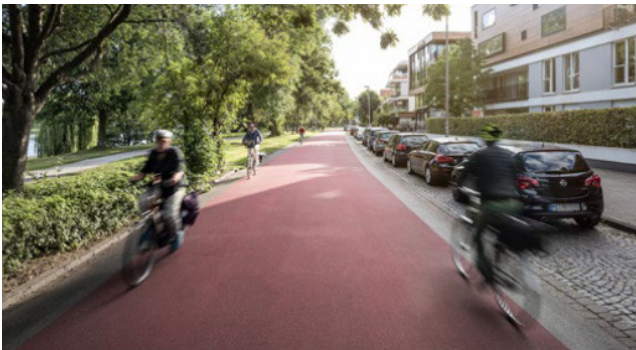
Abb. 44 Erschließungsstraße in Münster nach dem Umbau zur Fahrradstraße; Quelle: Broschüre Einladende Radverkehrsnetze, Bundesministerium für Digitales und Verkehr
