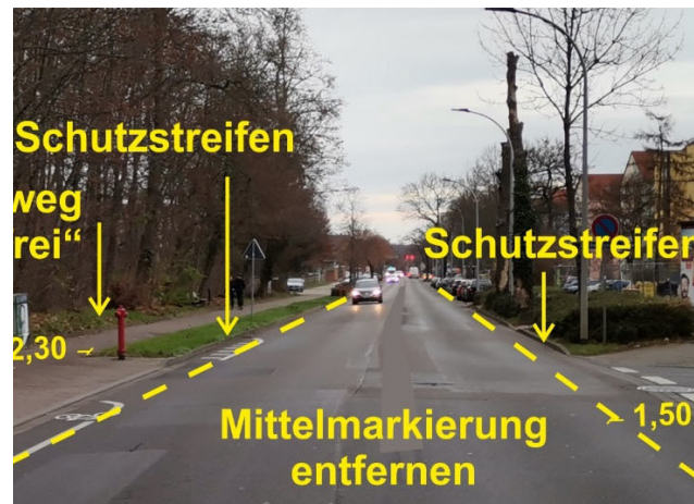
Abb. 42 Koburger Straße: Schutzstreifen; Quelle: VSC GmbH
