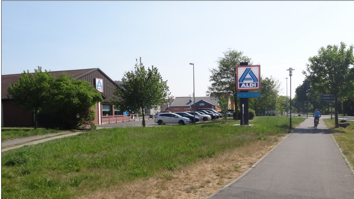
Abb. 7: Blick auf das Plangebiet in Richtung Süden (05/2020)
