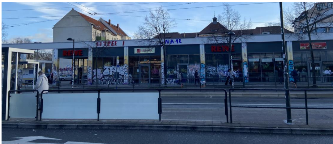
Abbildung 18: Blick auf den Rewe-Verbrauchermarkt im D-Zentrum Connewitz in Leipzig
