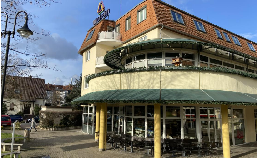
Abbildung 17: Blick auf den Gebäudekomplex des NVZ Trigaleria aus südlicher Richtung
