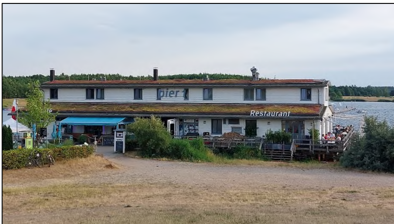
Abbildung 12: Kajüten/Betriebsräume im OG, Piergebäude, Hafenstraße 23a, NO-Fassade, IO 16/18 [41]
