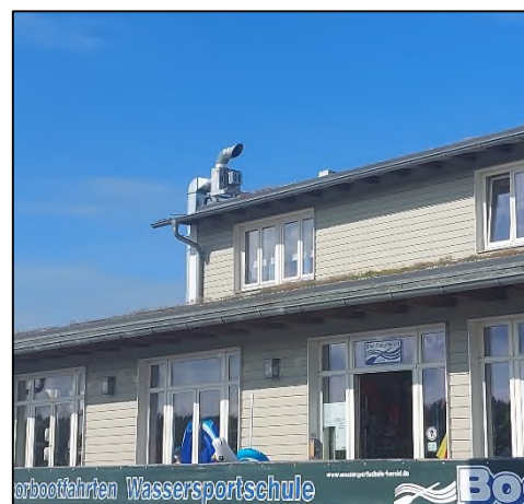
Abbildung 23: links: Abluftanlage auf dem Dach des Piergebäudes / rechts: Abluftanlage auf dem Dach des Hafengebäudes [41]
