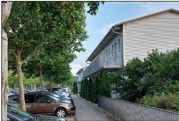
Abbildung 9: Ferienwohnungen, Haus 1/2, Hafenstraße 21, NO-Fassade, IO 11/13 [41]
