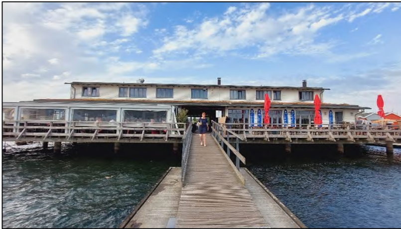
Abbildung 11: Kajüten/Betriebsräume im OG, Haus 1, Piergebäude, Hafenstraße 23a, SW-Fassade, IO 15/17 [41]
