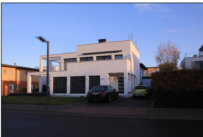
Abbildung 4: Wohnhaus Hafenstraße 14, IO 6; Hafenstraße 12, IO 5 [40]
