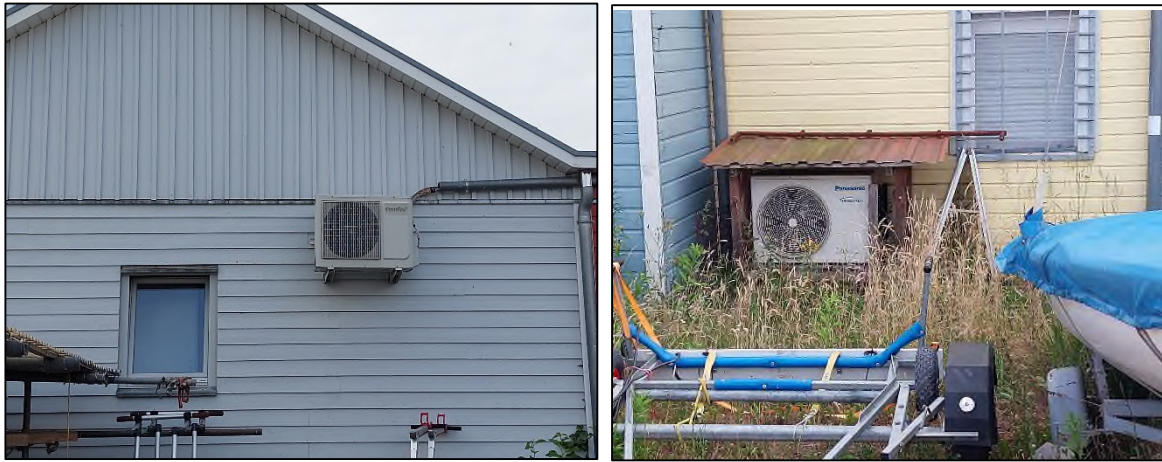
Abbildung 24: Außenklimageräte an Außenwänden (Gebäuderückseiten) im Bereich der Trockenliegeplätze [41] links: Segel- und Motorsportschule, rechts: Surfregal
