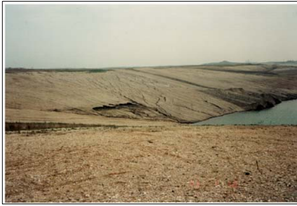
Abbildungen 2 und 3: Murenbildung im Bereich Kippenböschung 1996 (Aufn.: Götz, M.)
