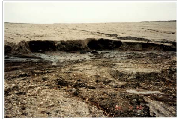
Abbildungen 2 und 3: Murenbildung im Bereich Kippenböschung 1996 (Aufn.: Götz, M.)
