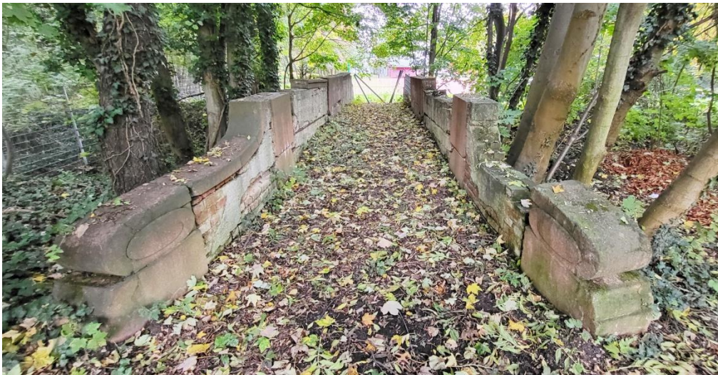
BW 26 – Brücke über den ehemaligen Floßgraben
