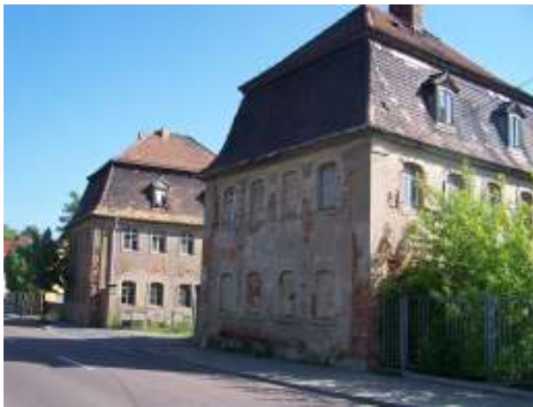
Torhäuser Gutsgelände Gaschwitz
