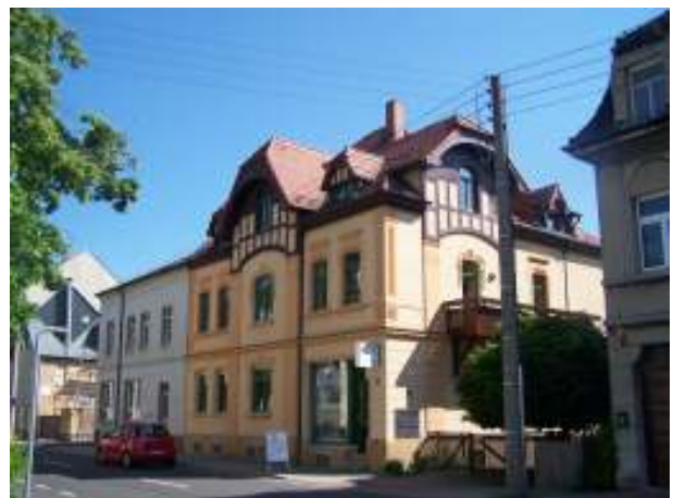
Sanierte Bausubstanz Hauptstraße 299
