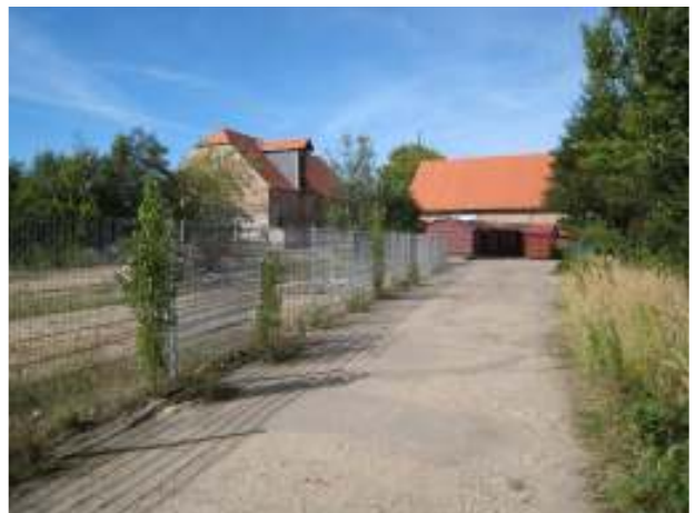
Platzgestaltungsmängel im Gutshof Gaschwitz
