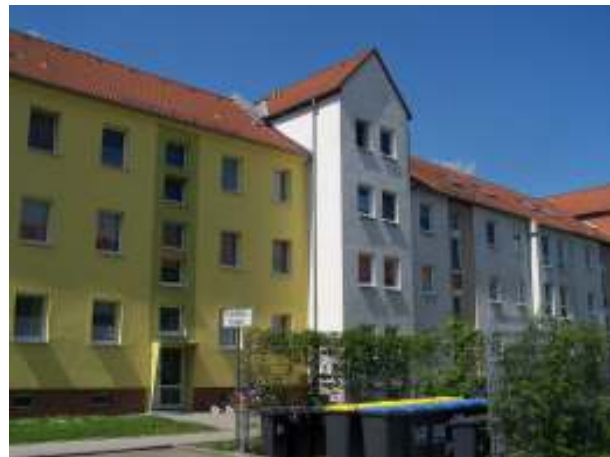
Sanierte Wohnzeile Straße des Aufbaus 36-45
