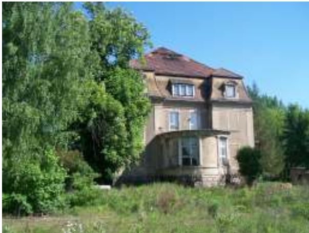
Brache Gutsgelände Gaschwitz ehemaliges Herrenhaus
