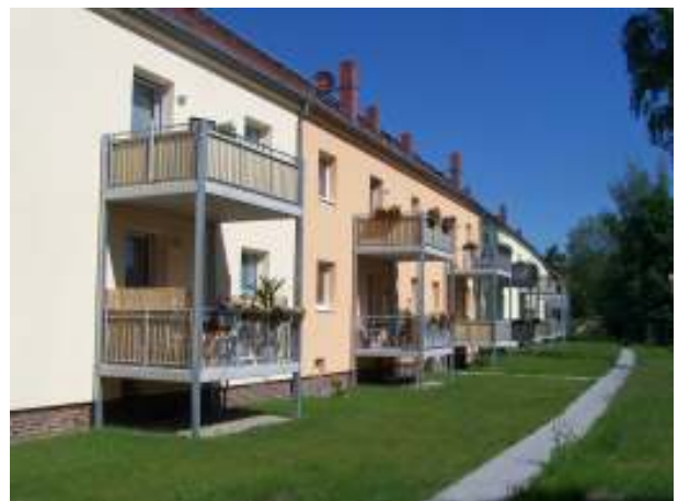
Sanierte Wohnzeile Hans-Steche-Weg 2-12
