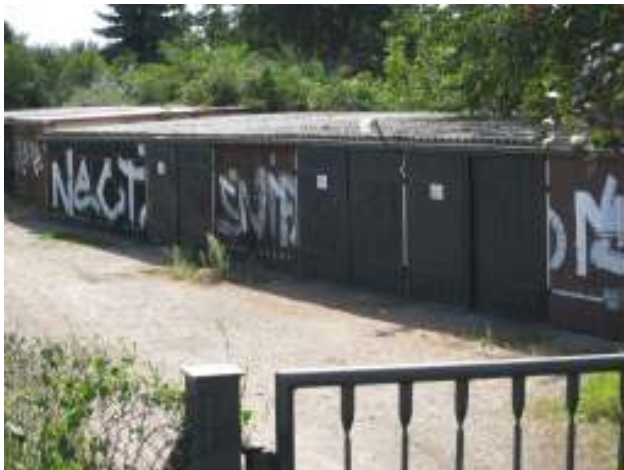
Garagenanlage Kleine Aue an der Pleiße
