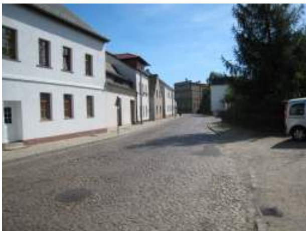
bauliche Erschließungsmängel Alte Straße, Großstädteln
