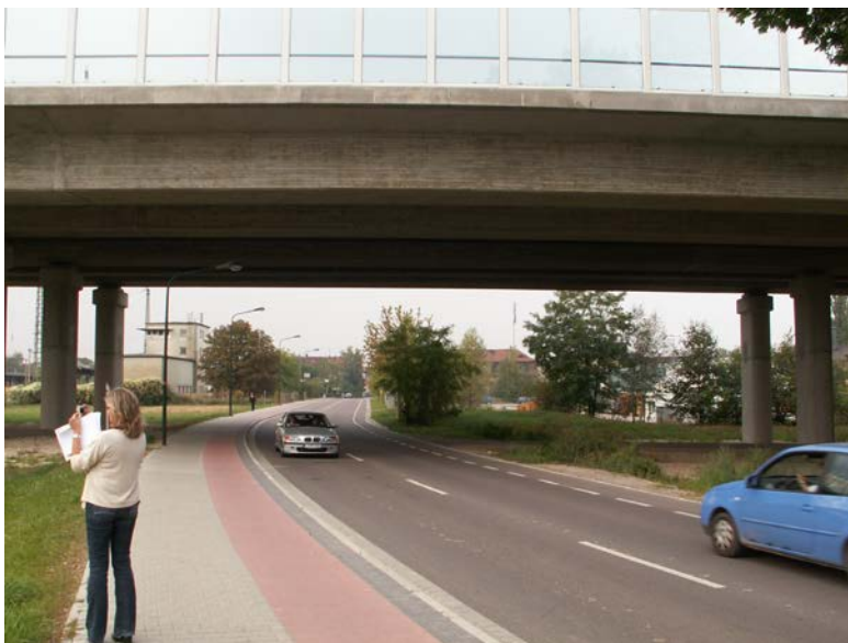
Hauptstraße (Gaschwitz) Zäsur der neuen A 38
