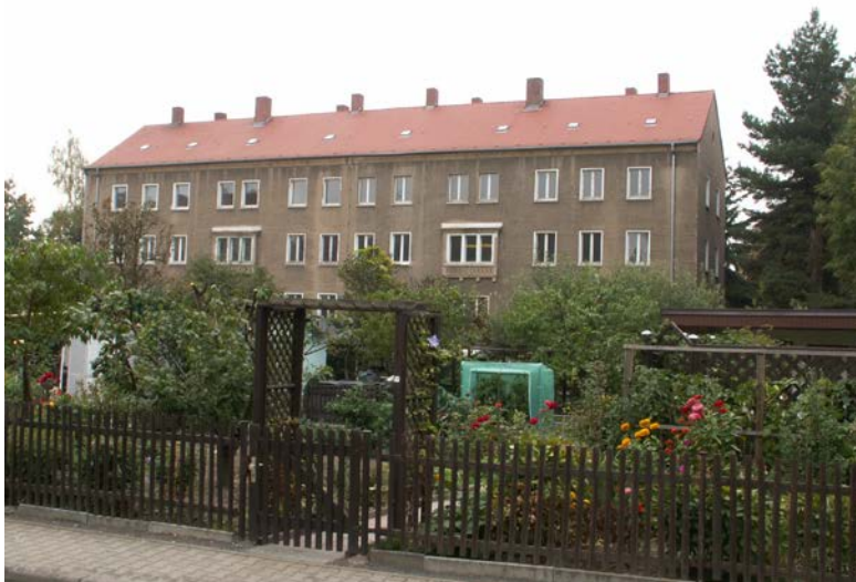
Am Park (Gaschwitz) teilsanierter Geschoss- wohnungsbau
