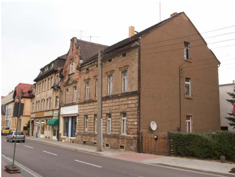
Teilgebietszentrum Gaschwitz Sanierungs- und Gestaltungs- bedarf
