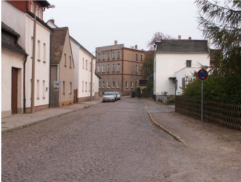
Alte Straße (Großstädteln) schlechter Zustand
