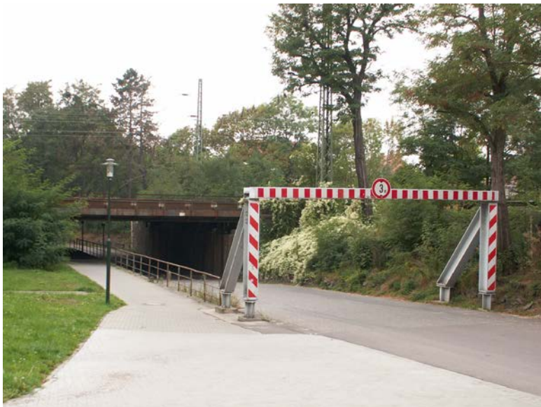
Gaschwitz und Großstädteln Bandstruktur westlich Bahntrasse Leipzig-Chemnitz
