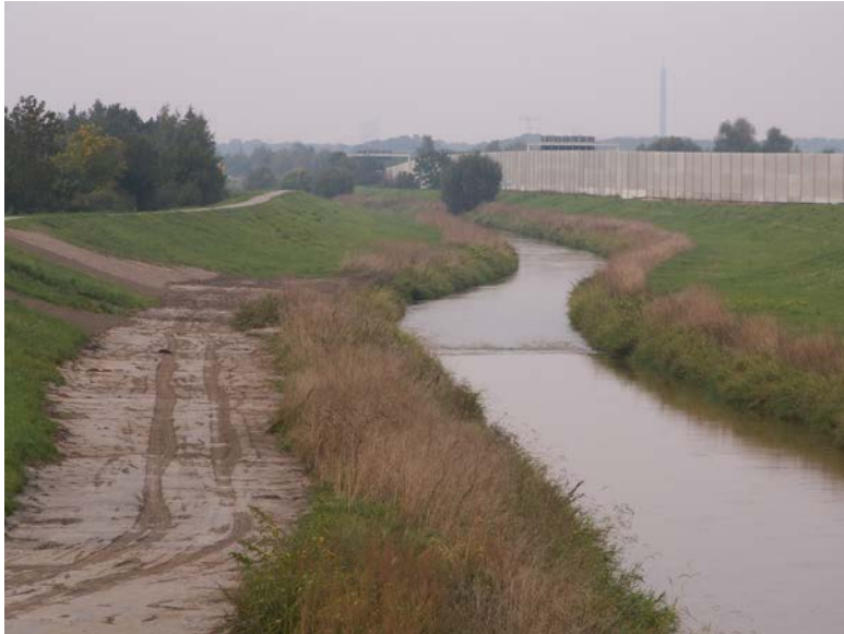
Gaschwitz und Großstädteln Bandstruktur östlich Pleißeradweg, Pleiße, Bundesstraße B 2
