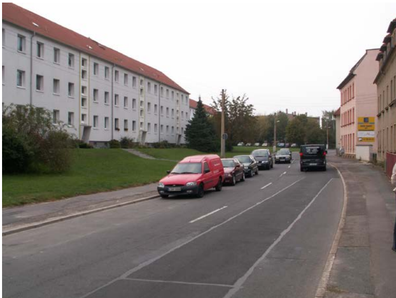
Hauptstraße (Großstädteln) unstrukturierte Bebauung, fehlende Raumkanten, nicht nutzbare Freiflächen, Verkehrsbelastung
