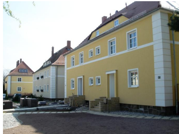
Oststraße 5, Gestaltung der Außenanlagen nach Gebäudesanierung (ohne Städtebaufördermittel)
