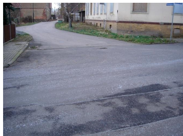
Cröbernsche Straße (2008) Kreuzungsbereich Blick Richtung Brunnengasse
