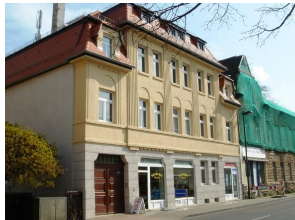
Hauptstraße 301 Sanierung mit Städtebaufördermitteln
