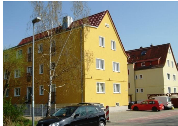
Neue Harth 6 Sanierung mit Städtebaufördermitteln
