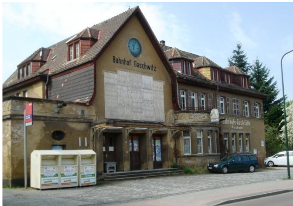
Hauptstraße 218 Bahnhof Gaschwitz - Handlungsbedarf
