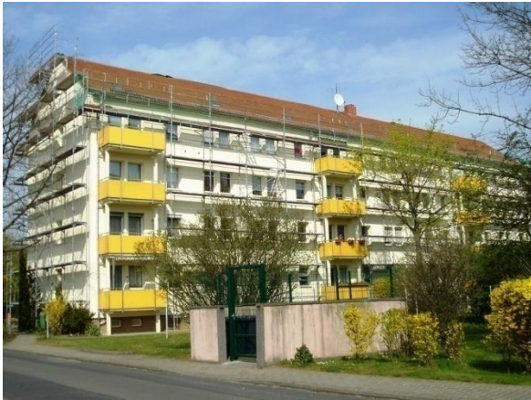
Am Park 2-6 derzeit Sanierungsmaßnahmen mit Städtebaufördermitteln
