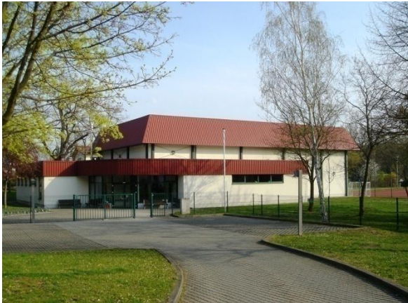
Hauptstraße 203 Turnhalle Großstädteln
