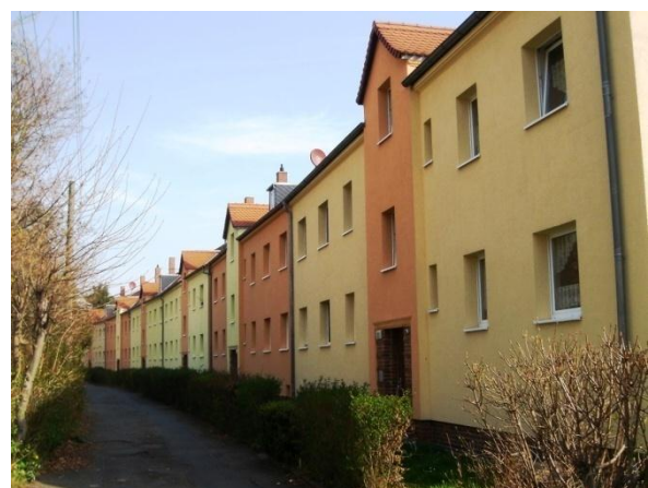
Hans-Steche-Weg 2-12 ohne Städtebaufördermittel saniert
