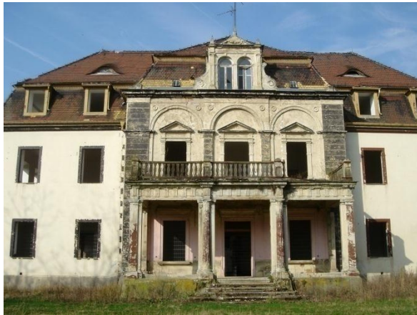
Hauptstraße 217 Herrenhaus - Leerstand, ruinöse Bausubstanz
