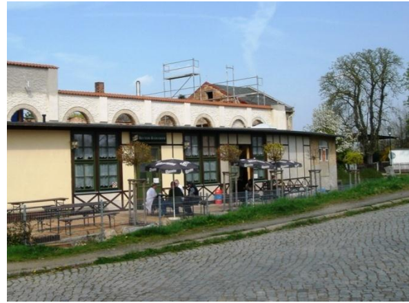
Cröbernsche Straße Missstand Fußweg
