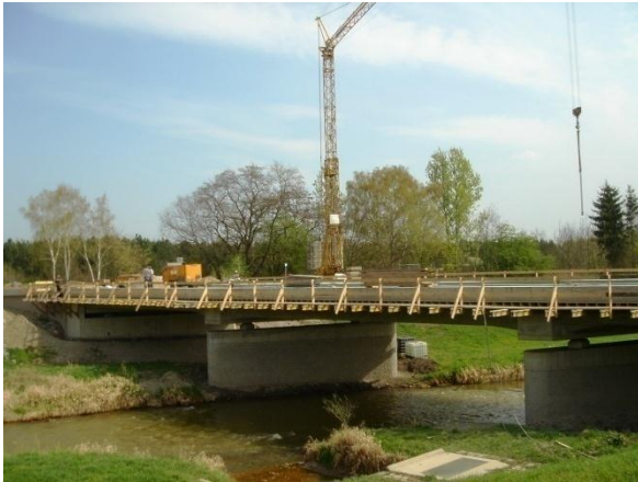
Neubau/Instandsetzung Pleißebrücke, I. BA nicht motorisierte Erschließung Richtung Markkleeberger See
