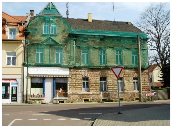
Hauptstraße 303 Sicherungsmaßnahmen an Fassade
