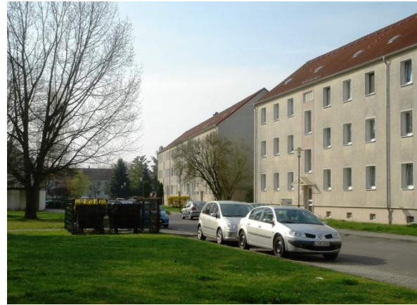
Straße des Aufbaus 11-21 WDVS mit leichtem Verschmutzungsgrad
