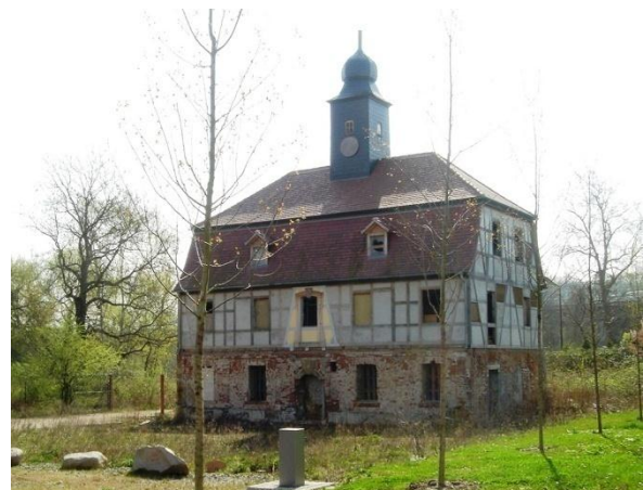
Hauptstraße 317, Altes Herrenhaus Gut Gaschwitz, erste Sa- nierungsmaßnahmen
