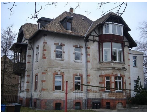
Hauptstraße 245 (2008) damalige Nutzung als Hortgebäude
