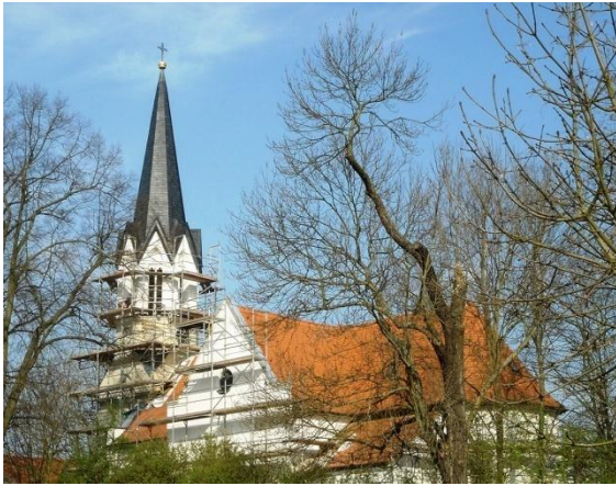
Kirche Großstädteln derzeit in Sanierung
