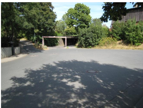
Kreuzungsbereich Schachtweg/Neuer Harth Defizite im Kreuzungsbereich
