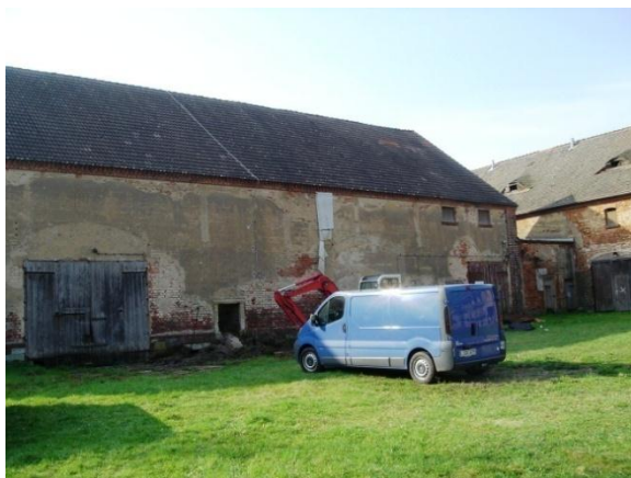
Hauptstraße 219 Gutsscheune mit Handlungsbedarf
