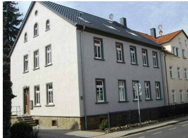
Hauptstraße 302 Sanierung mit Städtebaufördermitteln
