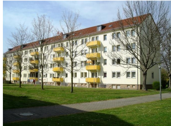
Am Park 8-16 Sanierung mit Städtebaufördermitteln
