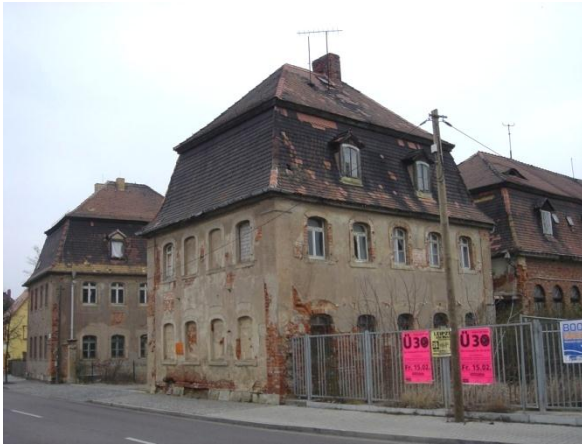
Hauptstraße 313/315 (2008) Torhäuser Gut Gaschwitz
