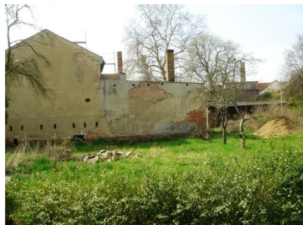
Cröbernsche Straße 13 Gestaltungsbedarf an privater Freifläche
