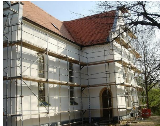
Kirche Großstädteln Sanierungsarbeiten Kirchenschiff
