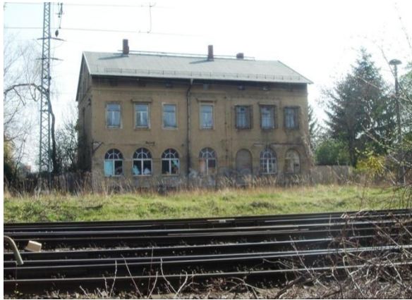
Alte Straße 18 Prüfung Rückbau
