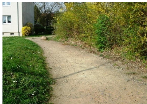
Fußweg Hauptstraße Richtung Straße des Aufbaus Defizite
