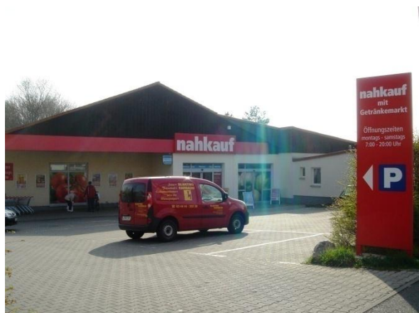
Hauptstraße 229 Sanierung mit Städtebaufördermitteln
