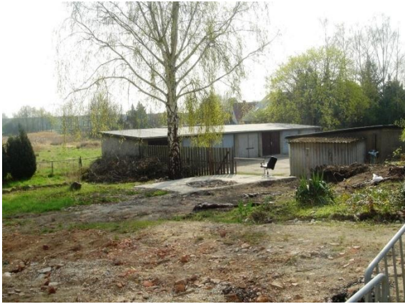
Hauptstraße 237 erfolgter Rückbau, Nachverdichtungspotenzial
