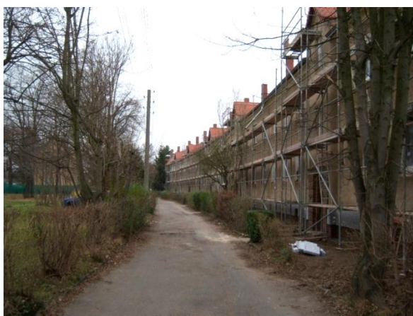
Hans-Steche-Weg 2-12 (2008) Beginn der Sanierung
