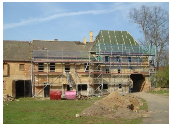
Hauptstraße 219 Torhaus derzeit in Sanierung (links angrenzend Speicher)
