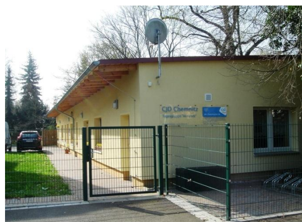
Gustav-Meisel-Straße 7, CJD Chemnitz, Tagesgruppe „Horizont“, Sanierung mit Städtebaufördermitteln
