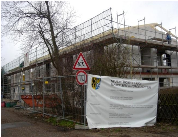
Alte Ziegelei (2008) Bauphase Neubau Hortgebäude
