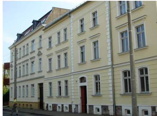
Cröbernsche Straße 4/6 mit Städtebaufördermitteln denkmalgerecht saniert
