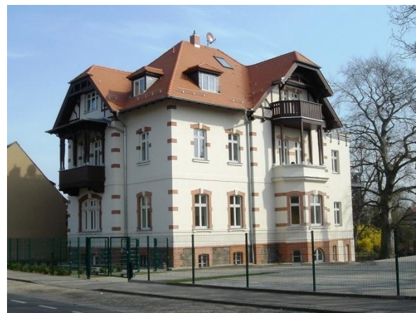
Hauptstraße 245 heute Wohnnutzung, Sanierung ohne Städtebaufördermittel
