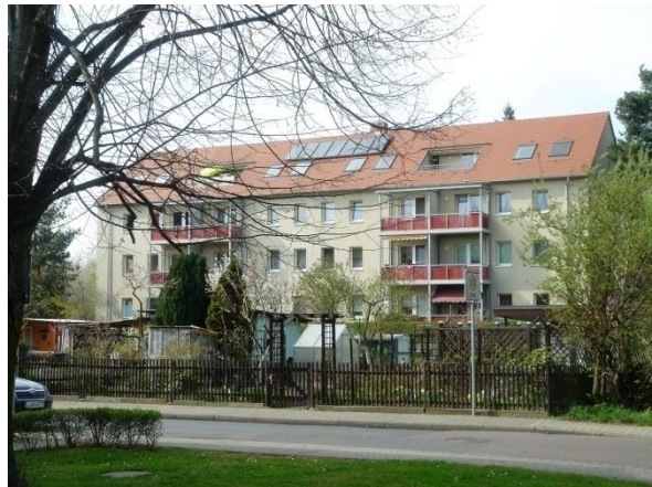
Hauptstraße 334/334a mit Städtebaufördermitteln energetisch saniert
