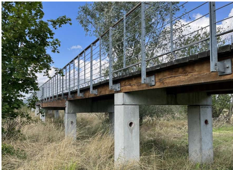
Brückenansicht Bereich Abbruch-Bestand
