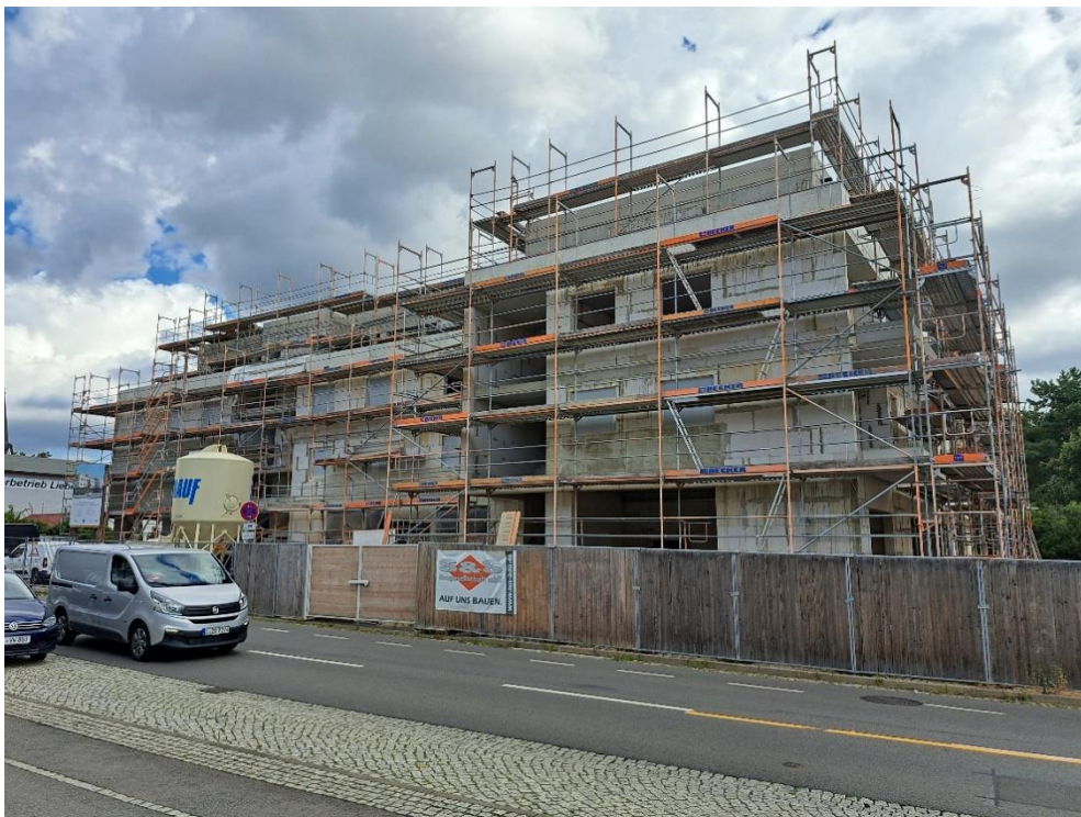
Abbildung 2 Der Rohbau für das neue Nahkauf-Objekt im August 2024.
