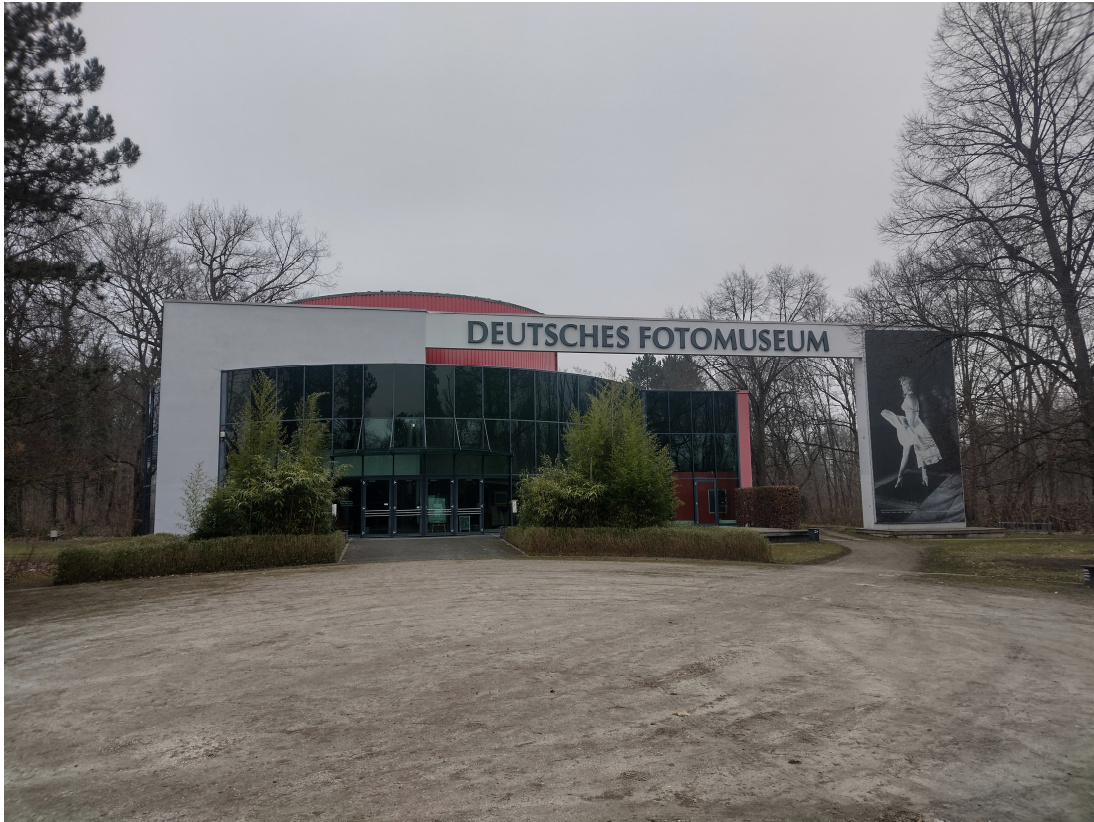
Lfd. Nr.: 01 Datum: 09.04.2025 Bem.: Ansicht außen von Süden
